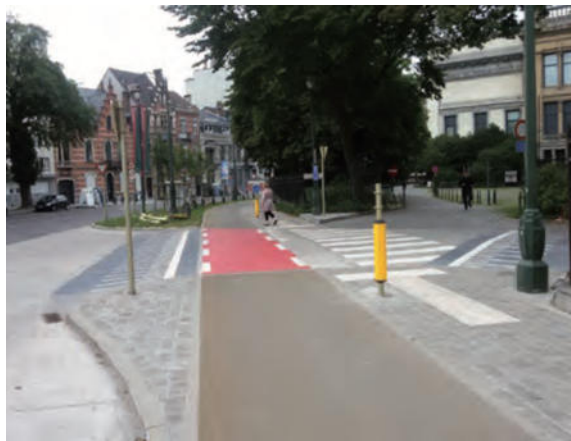
Abbildung 8: Rote Markierung von Gefahrenstellen, Brüssel
