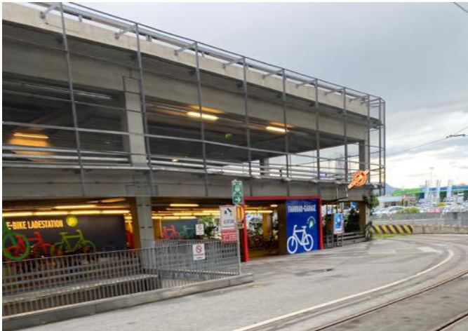
Teil eines Parkhauses: Fahrradgarage beim Murpark
