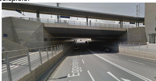
Unterführung Eggenberger Gürtel beim Hauptbahnhof
