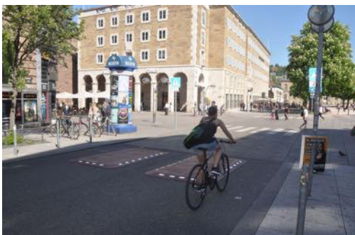
Beispiel für Bodenschwellen, Quelle: https://www.stuttgarter-zeitung.de/gallery.stuttgarter-innenstadt-stadt-bremst-ps-fanatiker-aus-param~2~1~0~5~false.23b25f04-8da2-43e5-b4b4-8ad197215156.html
