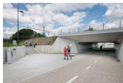
Unterführung mit Geh- und Radweg
