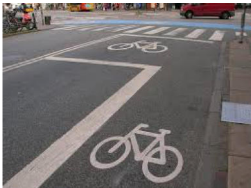
Beispiel einer Bike-Box mit zuführendem Radfahrstreifen
