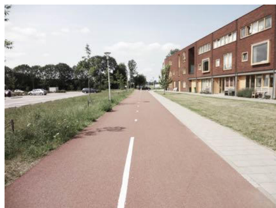
Abbildung 6: Roter Asphalt (Radschnellweg)
